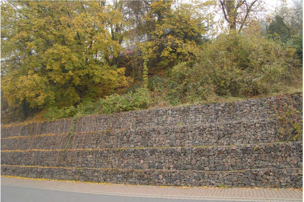
Foto 2 Gabionen am Hangfuß entlang der Hauptstraße mit Baum- und Strauchvegetation unterhalb des Wohnhauses, das sich im Geltungsbereich befindet
