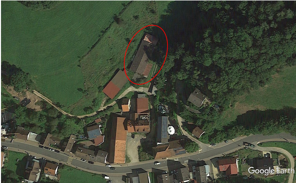
Abb. 1: Schematische Darstellung und Lage des Gebäudes (rot), das abgerissen werden soll.
