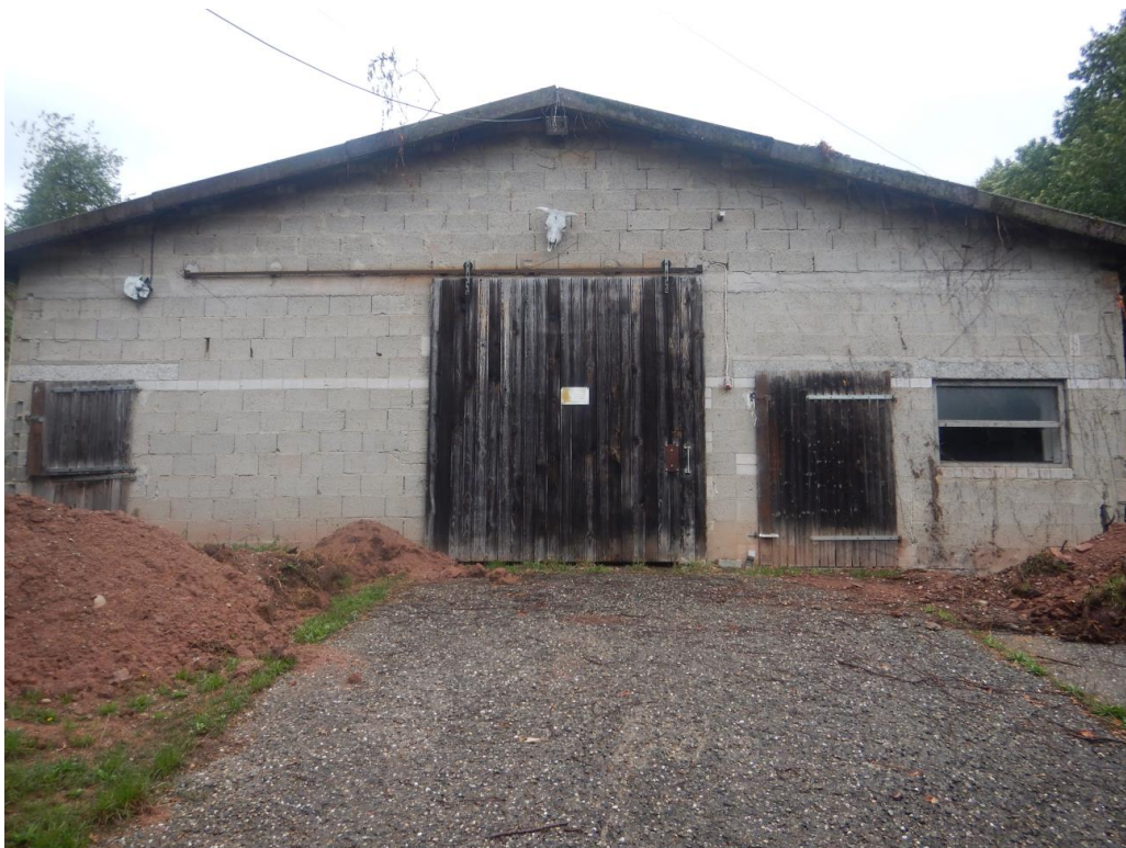
Abb. 2: Blick auf den Stall der abgebrochen werden soll.
