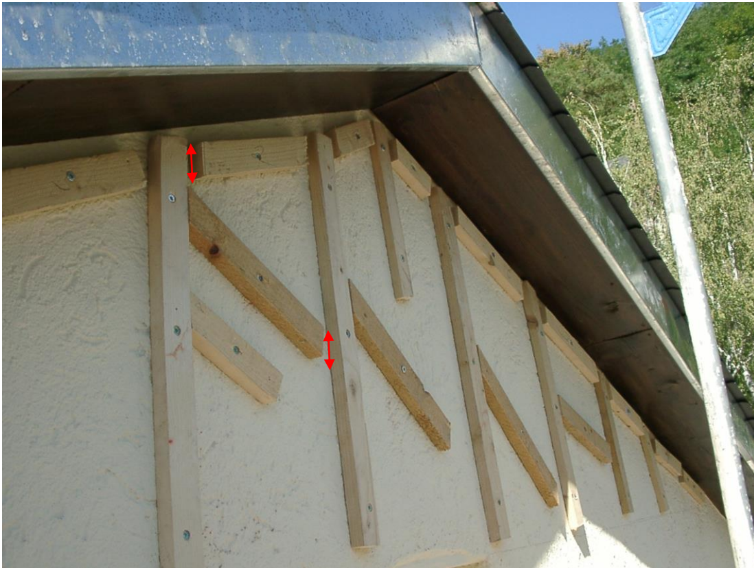
Abb. 10: An den Giebelseiten wurde eine Nut-Federverschalung mit spezifischer Lattenkonstruktion hergestellt, so dass die Muttertiere ihre Jungtiere auf die Dachlatten ablegen können, nicht aber sich Kot ansammeln kann. Die Fledermäuse müssen innerhalb der Lattenkonstruktion überall hin krabbeln können, so sind an allen Latten „Durchlässe“ (rote Pfeile als Beispiel von Durchlässen) vorzusehen, so dass keine Barrieren/Sackgassen entstehen.
