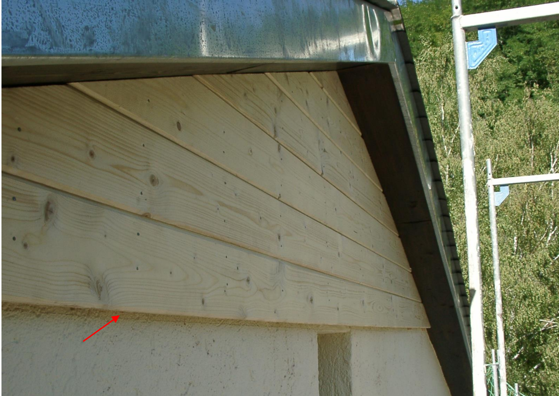
Abb. 12: Hier mit Nut-Federbrettern verschalt, die Einflugbereiche befinden sich in bestimmten Abständen unter dem Abschlussbrett (Pfeil).
